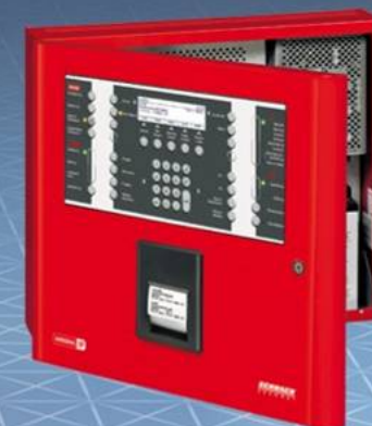
Obudowa z panelem obsługi i drukarką protokolującą
